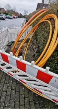
Von dort führen dann dünnere Leerrohre in die Häuser. In diese dünnen Leerrohre werden die Glasfaserleitungen dann in die Häuser „eingeblassen“. Vielleicht wird es schon im Frühjahr die ersten aktiven Hausanschlüsse geben.
